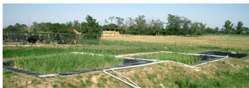
I.1. fotó: A hódmezővásárhelyi mintatelep látképe; előtérben a függőleges-, középben a hosszanti átfolyású műtárggyal, a háttérben az utótisztító tóval. (balról jobbra)
