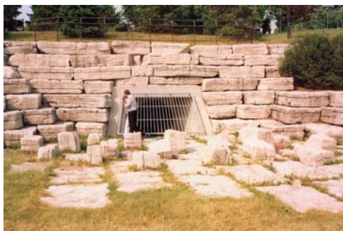
3.36. ábra. Száraz tározó és beömlő műtárgya Kanadában (fotó: Gayer J.)
