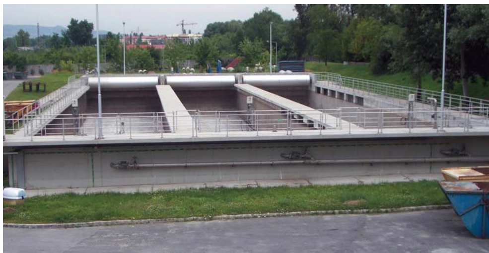
3.39. ábra. A dél-desti szennyvíztelep záportározója (fotó: Gayer J.)
