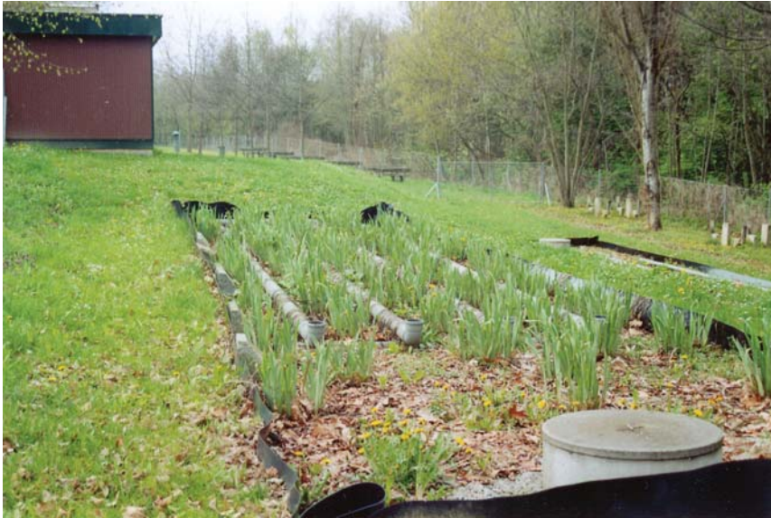
3.43. ábra. Autópálya tisztálkodási épülete mellé épített gyökérszóna (fotó : Ligetvári F. )
