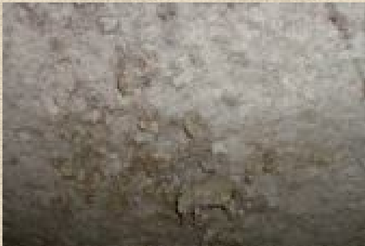
3. kép: Hőszigetelésre használt azbeszt a mennyezeten
