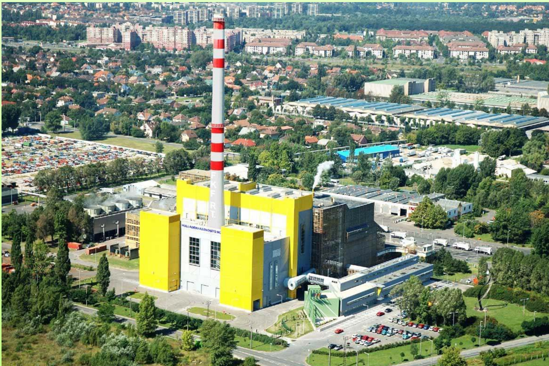
Hulladékhasznosító Mű a rekonstrukció után
