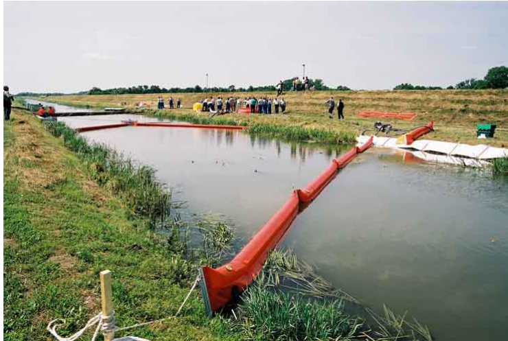
1. kép: Telepített SHOREGUARDIAN merülőfal
